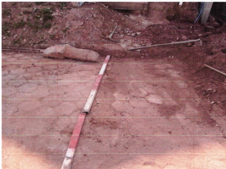
OS 2231059406 – Data da primeira execução 20/09/2022 – Reposição de Bloquete Endereço: AV. ARGEMIRO RAMOS DE SIQUEIRA, 323
