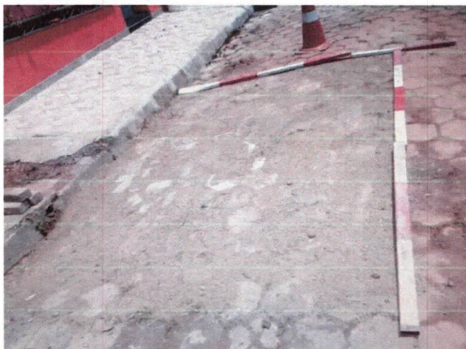
OS 232073508 – Data da primeira execução 25/01/2023 – Reposição de Bloquete e calçada Endereço: R. CLAUDINO DE SOUZA, 246
