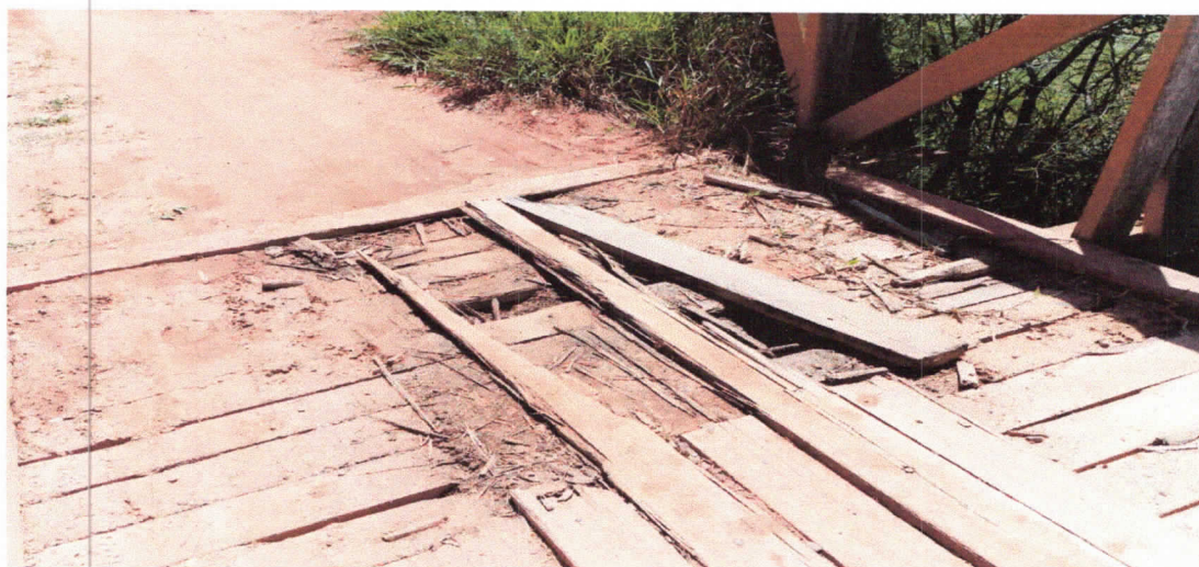
Ponte próximo ao bairro do Serrotinho
